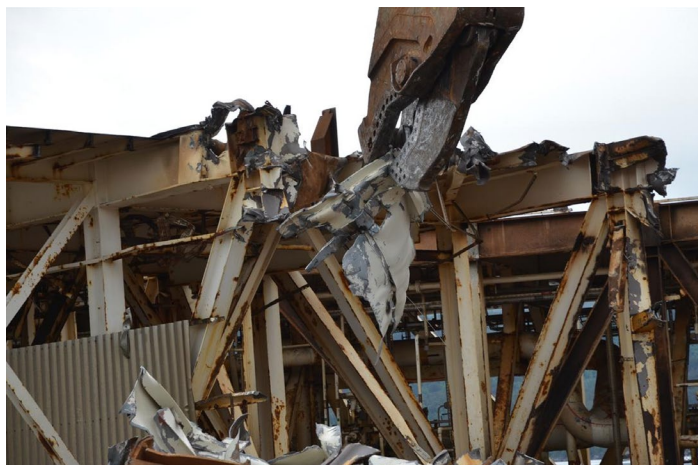
Figur 7-4. Eksempel på klipping av stål i dekksmul.
