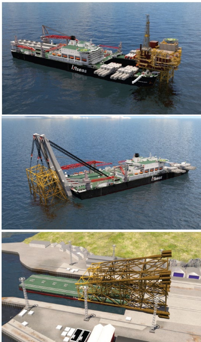
Figur 2-15. Eksempel på fjerning av hhv dekkсанlegg med ettløfts fartøy, kranløft av stålunderstell og overføring av dette til land. Kilde: Allseas.
