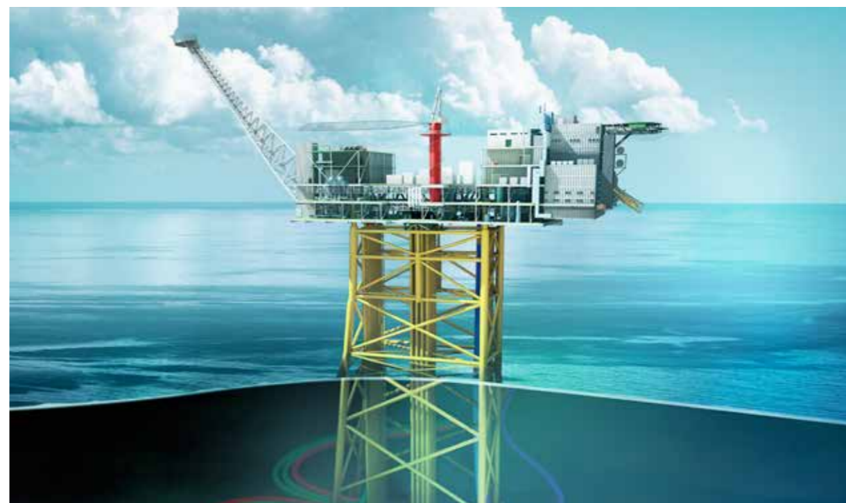
Byggast i Singapore: Overdelen på plattformen til Ivar Aasen-feltet er 13 700 tonn og skal byggast av SMOE i Singapore. Integrert i plattformen er eit bustadkvarter til 70 personar og eit helikopterdekk. Kontrakta har ein verdi på omlag fire milliardar kroner.
