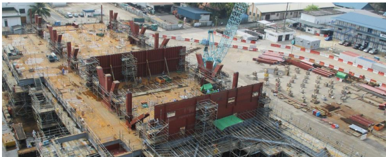
Konstruksjonen i henhold til plan
