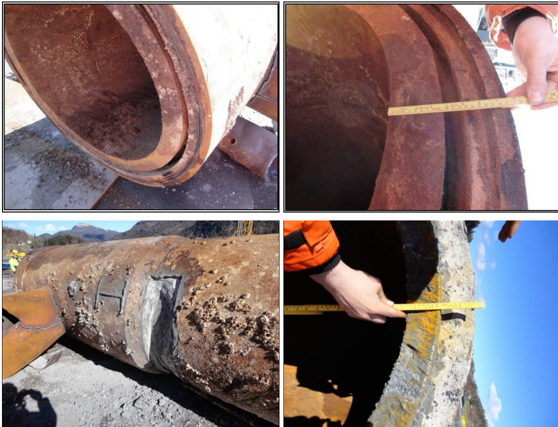
Figur 2-3. Foto som viser eksempler på dimensjon av fundamenteringspæler til stålunderstell og plattformbein (foto, DNV GL).
